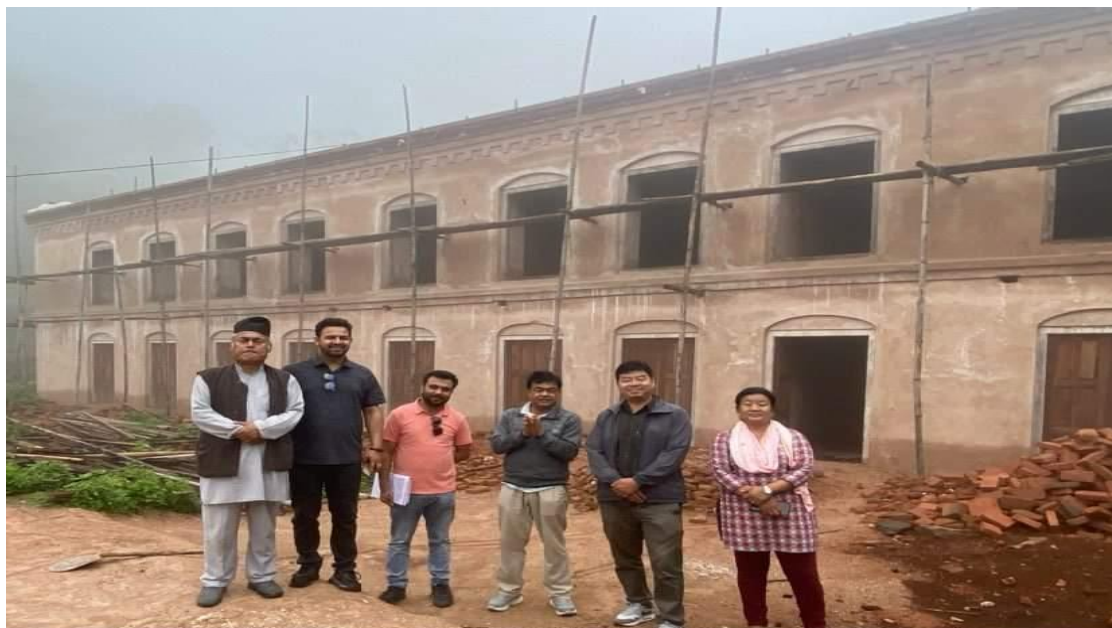
सिन्धुलीगढी दरबार पुनर्निर्माणको अवलोकन पछि लिईएको तस्बीर
